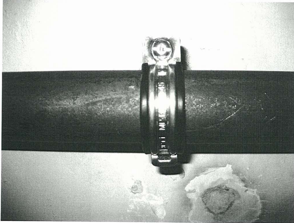
Bild 1: Rohrschelle Typ Hilti MP-LHI 38-45, Abstand zwischen den Schellenhälften 15 mm
