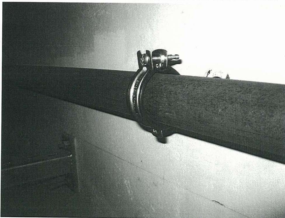
Bild 2: Rohrschelle Typ Hilti MP-LHI 38-45, Abstand zwischen den Schellenhälften 15 mm
